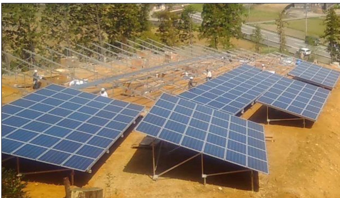
図 2-12 架台設置工事のイメージ
