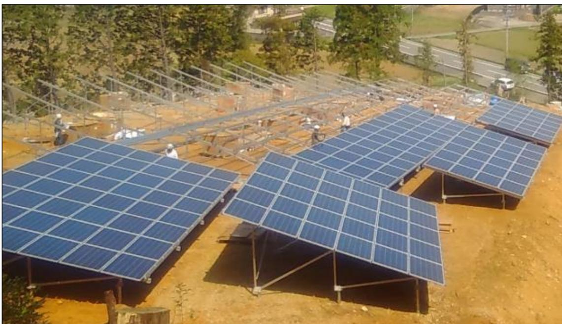
図 2-12 架台設置工事のイメージ
