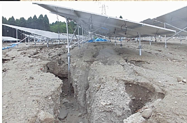
●深くえぐられた建設用地。「グラウンドキャニオン」と呼ぶ人も ●太陽光パネルの下の土台が深くえぐられていた いずれも11日、霧島市霧島永水、中村満雄さん提供
