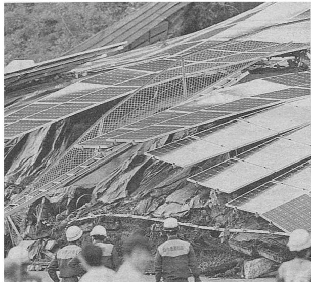
土砂崩れで損壊した太陽光パネル ＝2015年9月、仙台市
